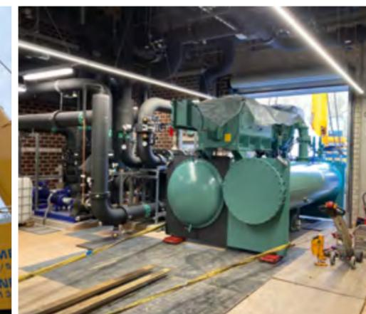
Die neue Kältemaschine ersetzt eine ältere aus dem Jahr 1973.
