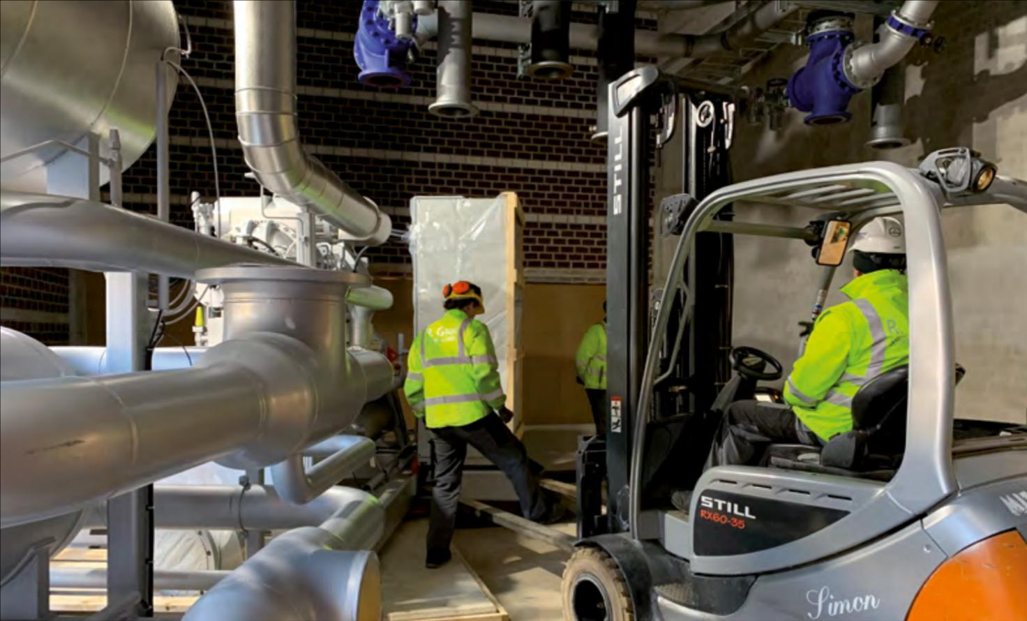
Millimeterweise wird gezirkelt, bis die neue Kältemaschine an ihrem Platz steht.
