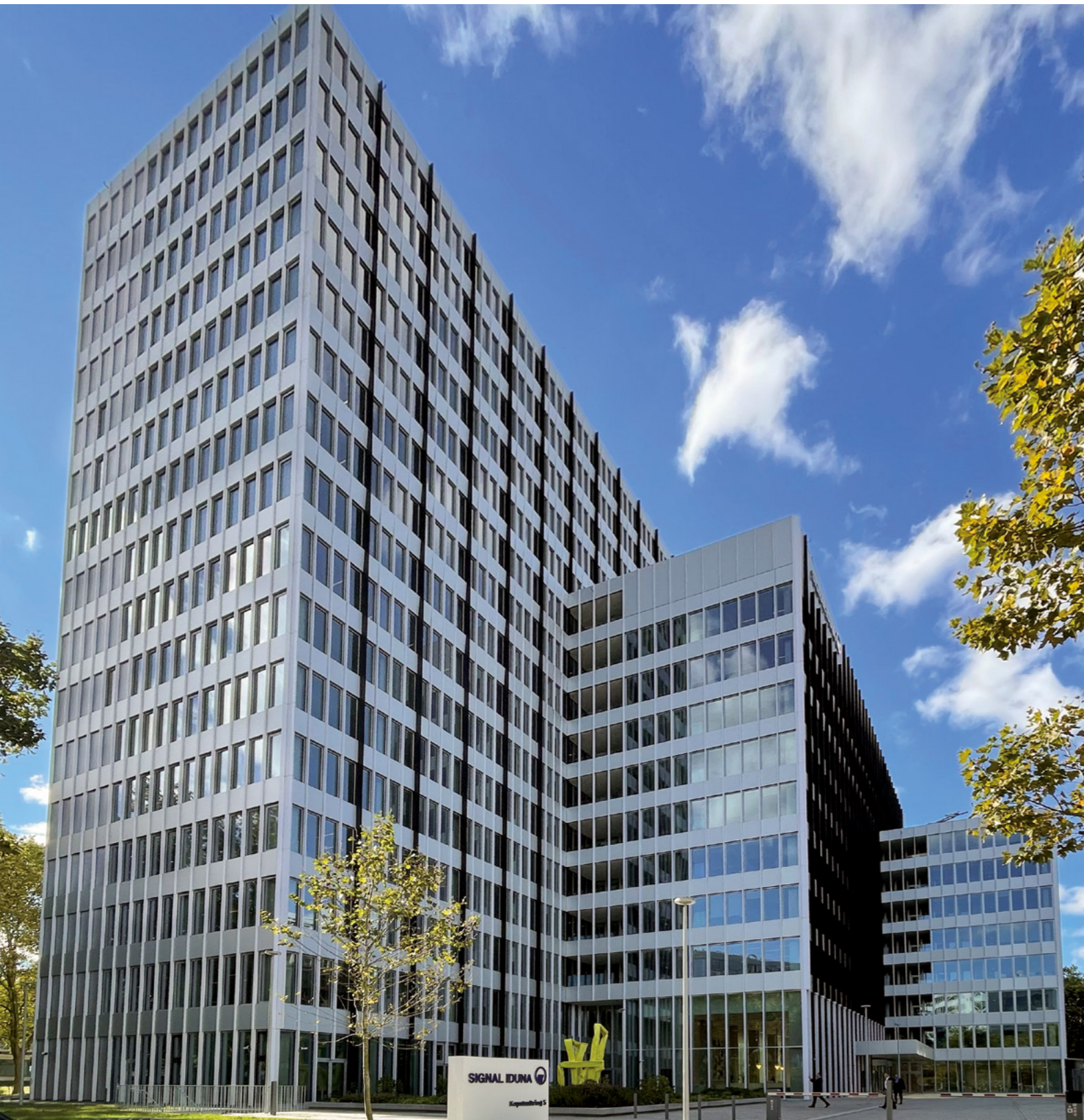
Fertiggestellt: Die neue SIGNAL-IDUNA-Zentrale am Kapstadtring 5.
